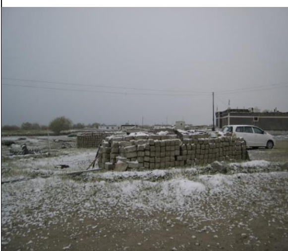
21 新雪のあった Merak の 6 月 18 日の朝 車の手前の積み荷は建物の建設に使用する日干しレンガ
