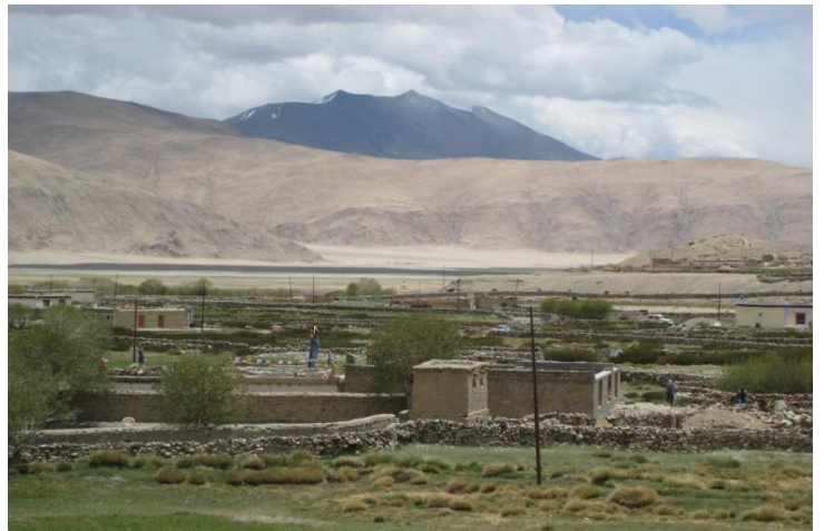
写真 20 Chushul の村の一部(軍の施設は山影にあり見えない)
